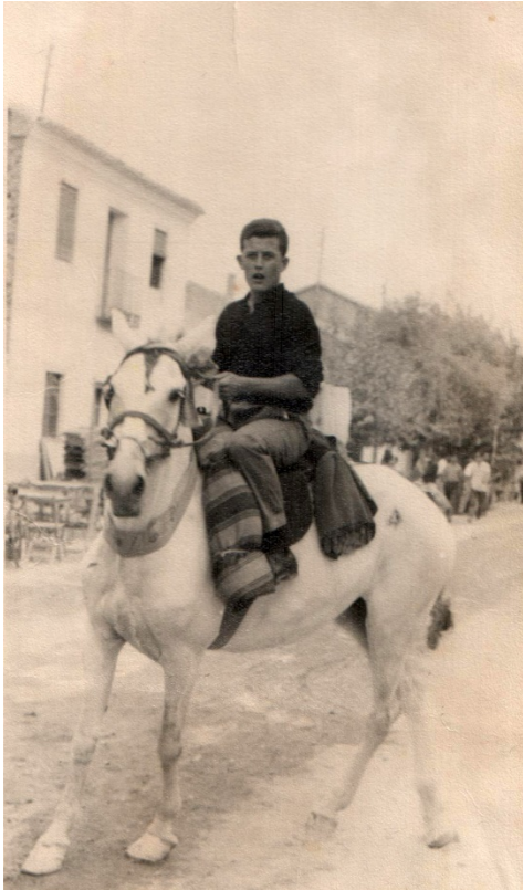
Detrás de este caballista, en la calle Mayor, se ve el edificio que acogía la escuela de niñas
